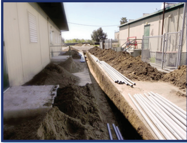
Resim 4.30: Enerji hatları için açılmış kanallar
