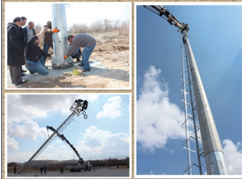
Resim 4.31: Vinç yardımıyla direk dikimi
